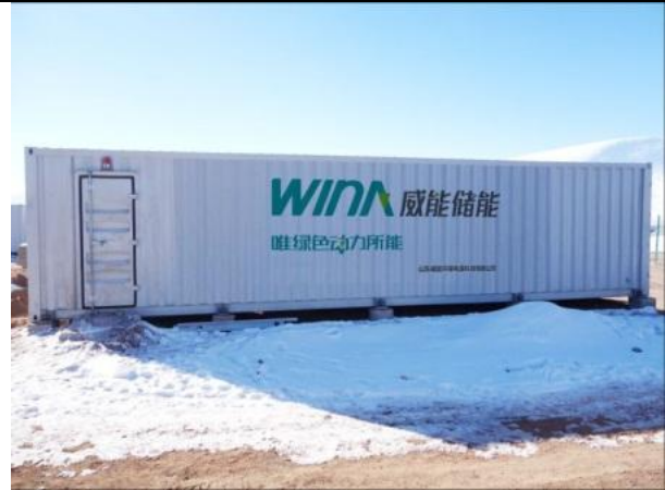
图16 集装箱储能系统
